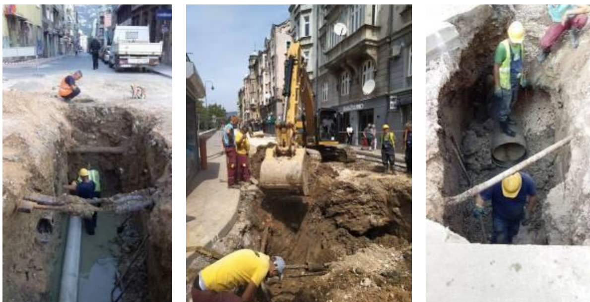
Slika 18. Rekonstrukcija vodovodne i kanalizacione mreže u ulici Koševska (avgust 2019.) 155
