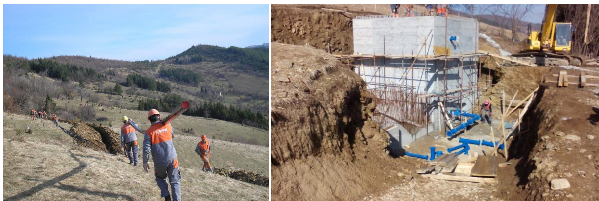
Slika 17. Radovi na izgradnji lokalnog vodovoda Klanica 134
